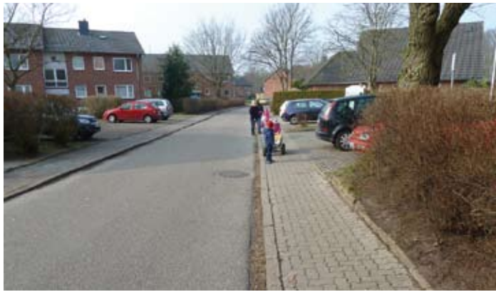
Berliner Straße beim Kindergarten. Der linksseitige Fußweg soll abgesenkt und gepflastert werden
